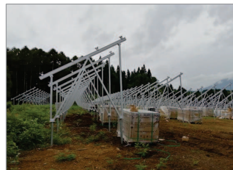
④架台設置
