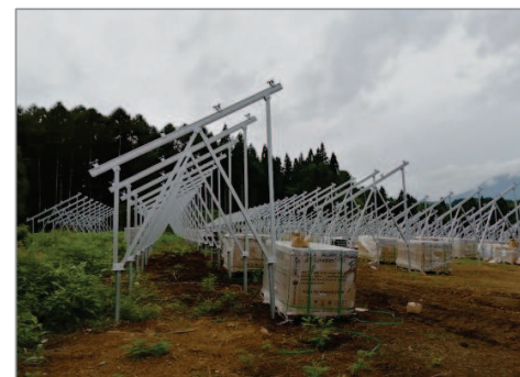
④架台設置
