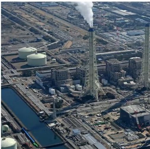
石炭など発電用燃料の価格高騰で業績が悪化している（東電が出資）
