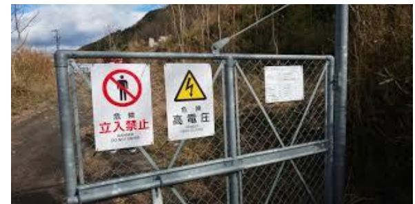
高圧発電所につき、フェンス、立ち入り禁止看板、連絡先などを表記し看板設置します
