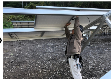
④パネル敷設
