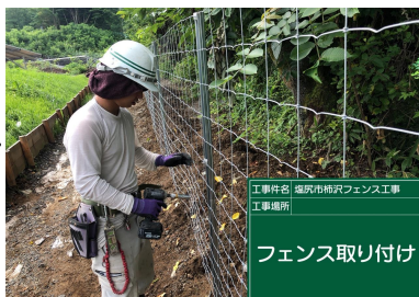
⑥フェンス設置工
