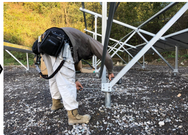
③架台組立工
