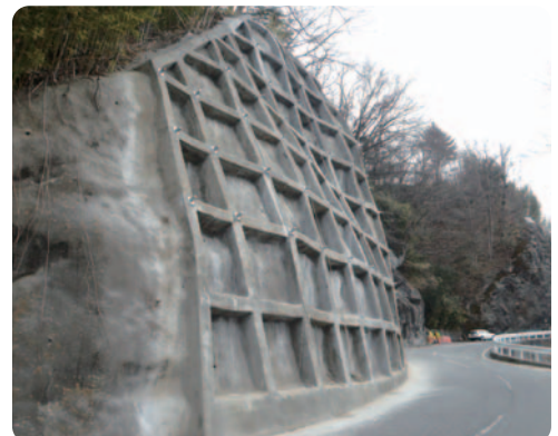
芝平高遠線 法面補修工事後（伊那市）
