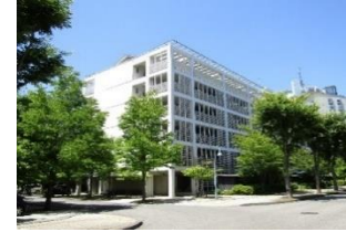
現有職員宿舎の長寿命化に向けた保全対策
