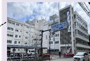
築60年を超える長野合同庁舎
