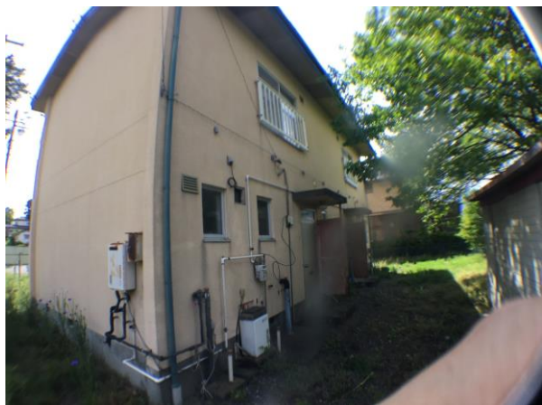
外観 北東から撮影
