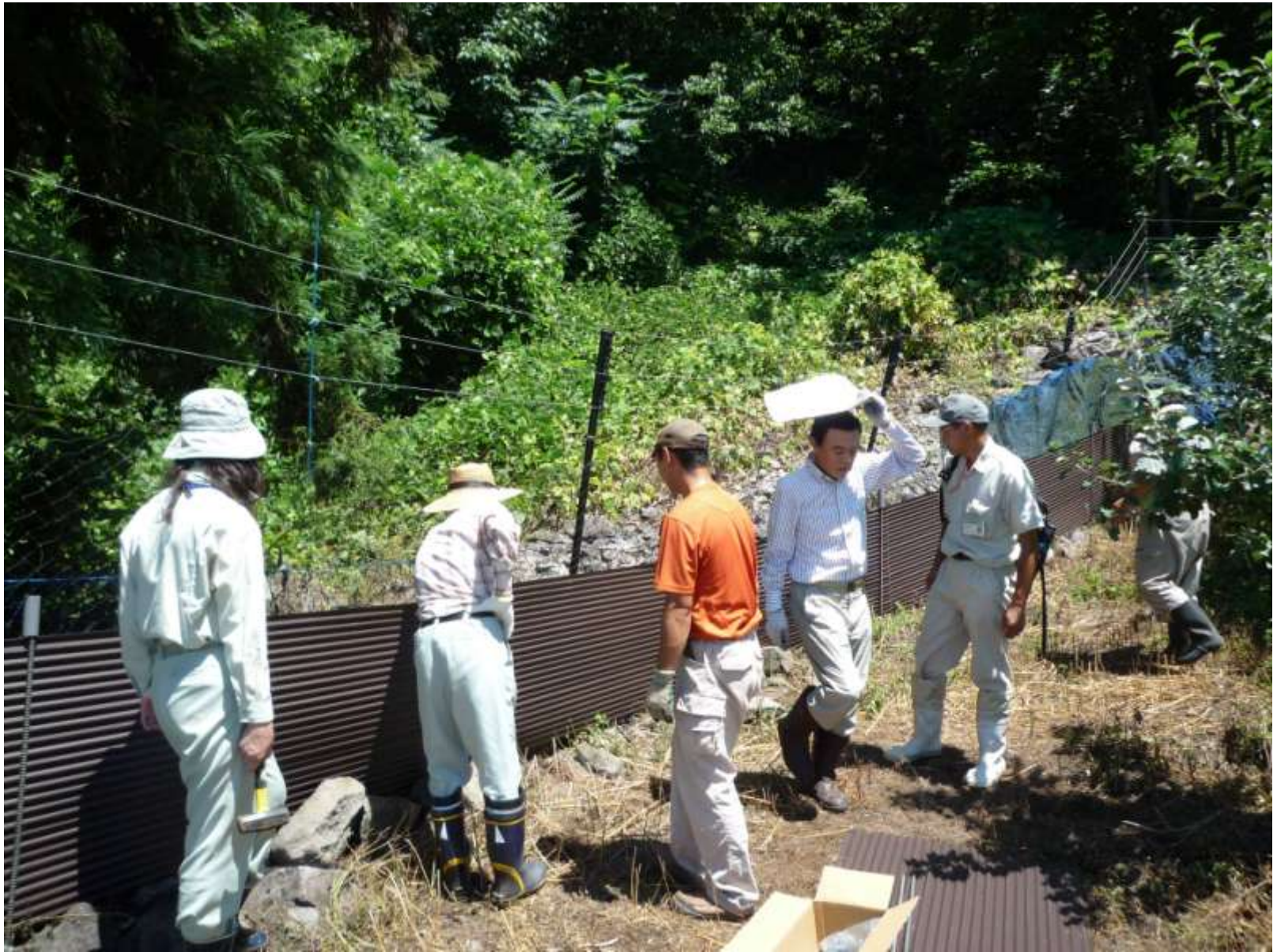
区の方と既存のサル用柵をイノシシ併用型へ改修、試作設置
