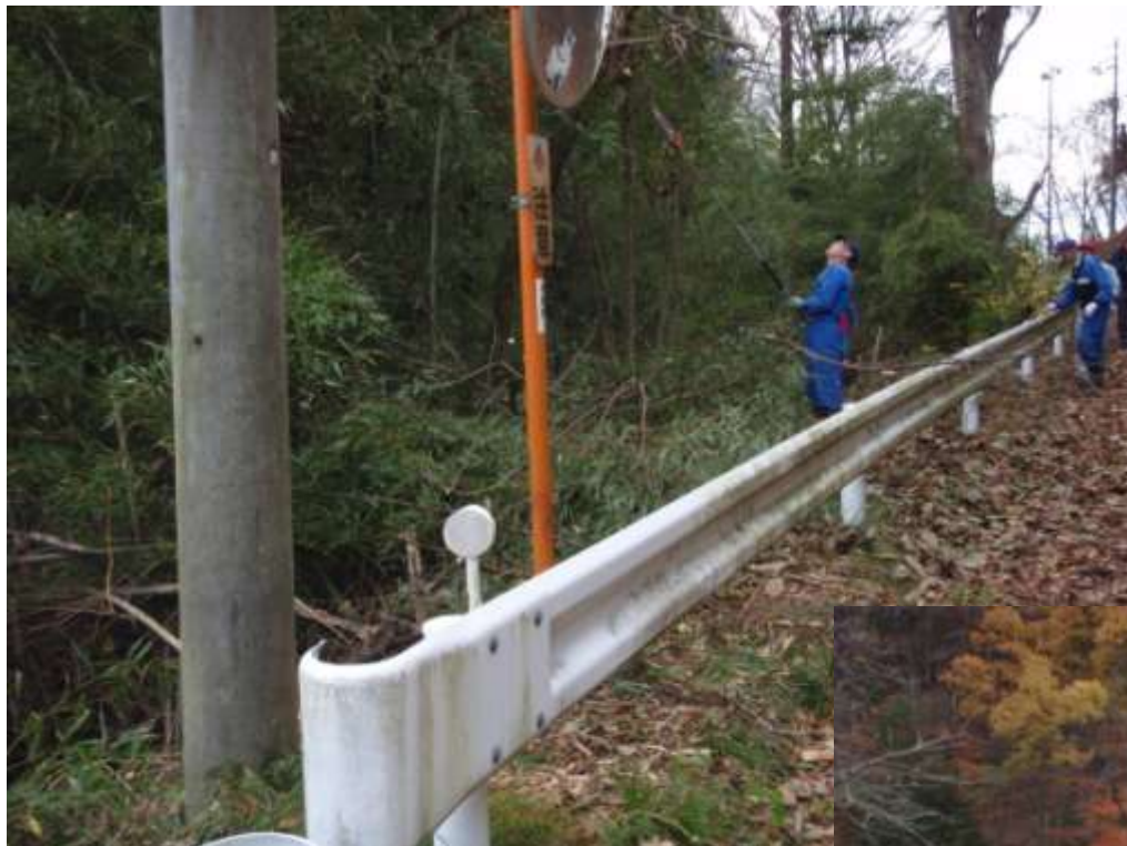
H21取組み町道脇 竹藪刈払い及び枝 払い作業
