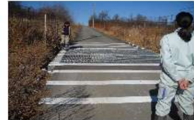
南牧村野辺山地区 野生鳥獣被害対策施設 グレーチング設置箇所
