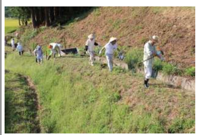
住民参加で設置中
