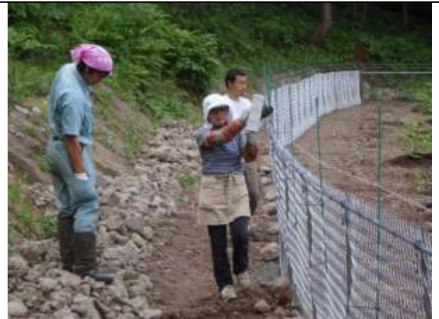
上部(サル、ハクビシン用電柵)を設置
