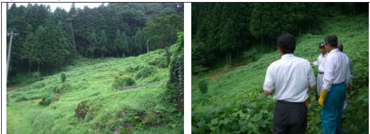
造成前……現地検討の状況
