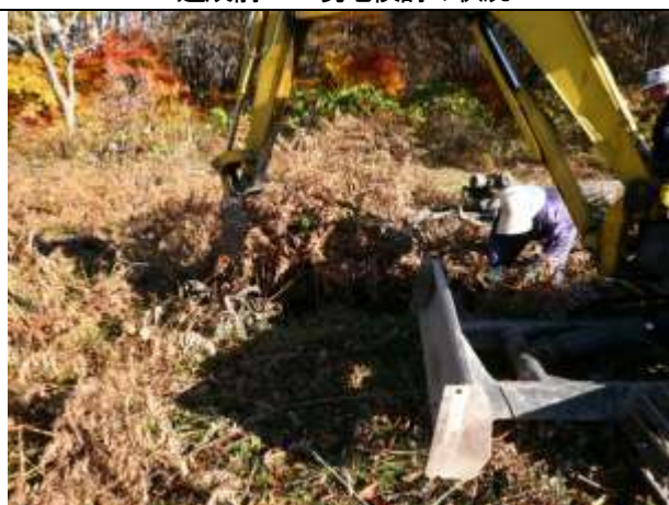
造成中……村の重機と住民の共同作業
