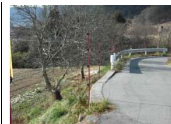
高さ確保のため、コンクリート路肩に設置
