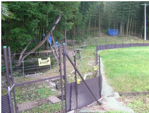
須坂市 防護柵出入り口
