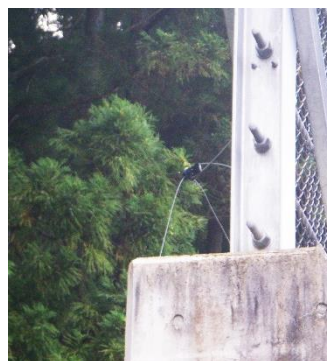
落石防護柵の電気柵設置の連携
