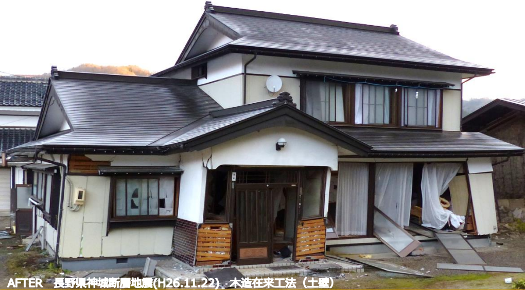
AFTER 長野県神城断層地震(H26.11.22) 木造在来工法(土壁)
