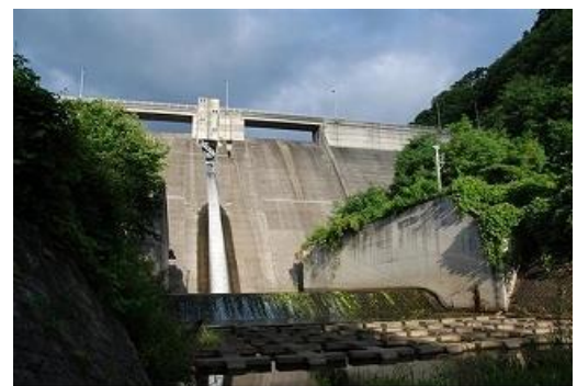
写真：内村ダム
