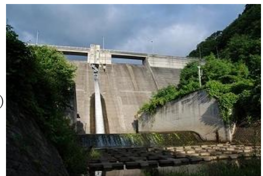
写真：内村ダム
