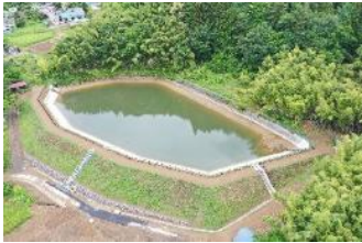
防災工事を実施した農業用ため池 (上田市山田新池地区)
