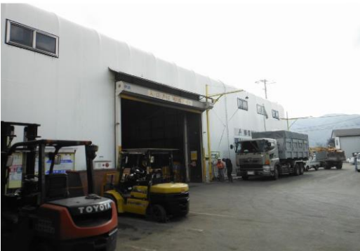
②A棟 外観 混合廃棄物
