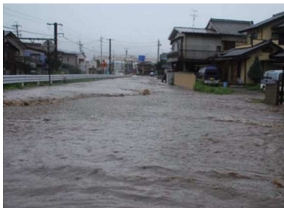
H18.7月豪雨による被災状況
