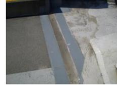
クラック補修、防水塗装で雨漏り対策を実施
