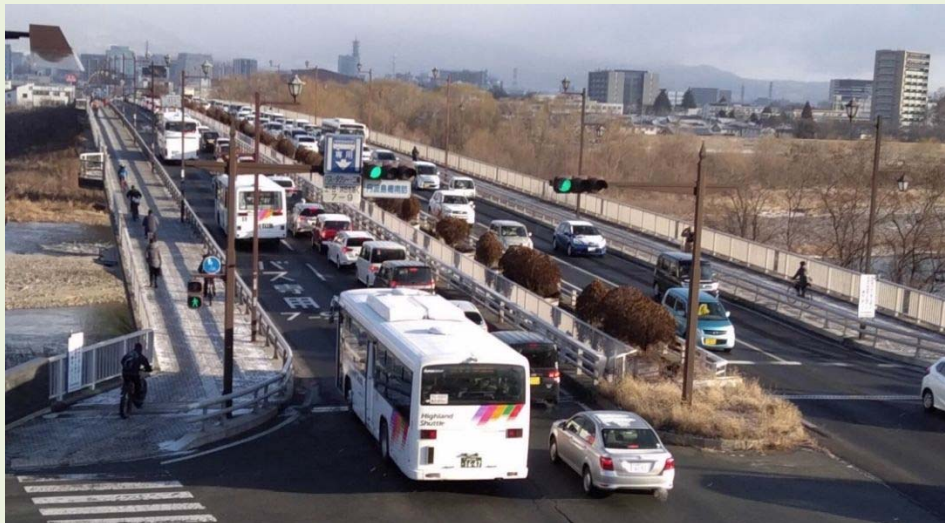
図 3.11 丹波島橋の交通状況
