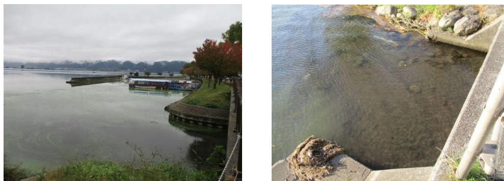
図 11.7.1.7 実施区域付近の状況（左：承知川河口、右：千本木川河口）
