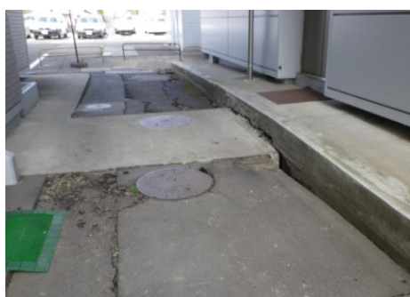
写 3-4 宅地地盤の沈下の例
