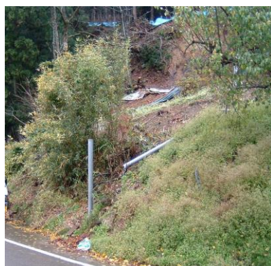
写 3-9 のり面のハラミ・盤ぶくれの例
