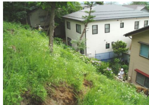
写3-8 のり面のクラックの例
