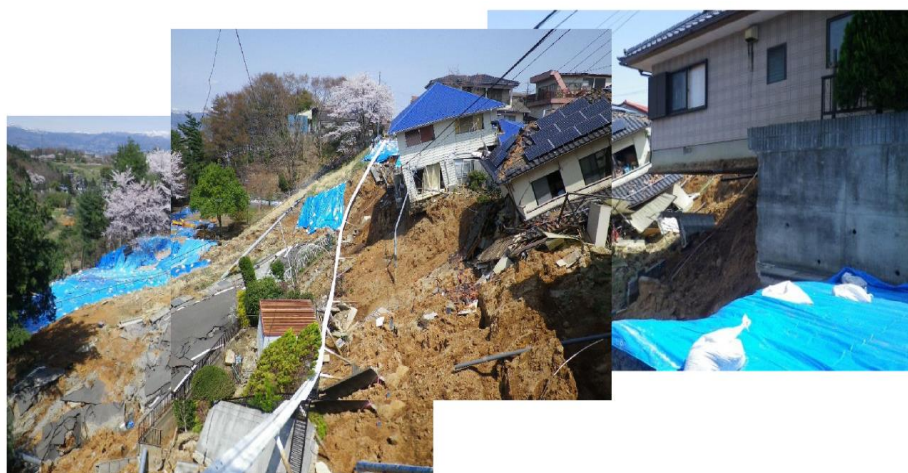
写 3-11 のり面の崩壊の例
