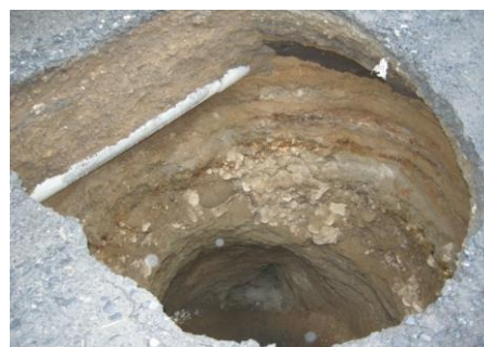
写 3-3 宅地地盤の陥没の例
