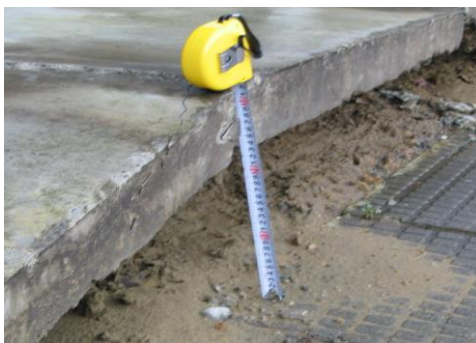
写 3-5 宅地地盤の段差の例
