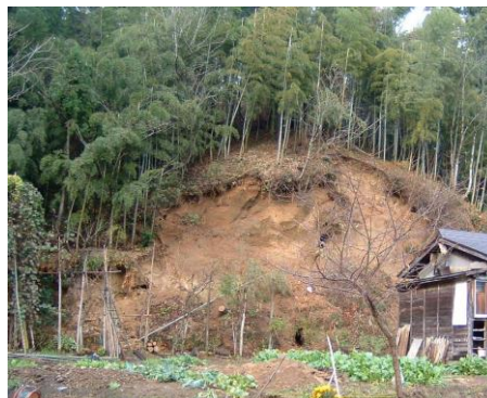
写 3-10 のり面のガリー浸食の例
