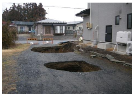
写 3-3 宅地地盤の陥没の例
