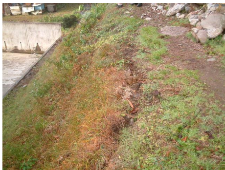
写3-8 のり面のクラックの例
