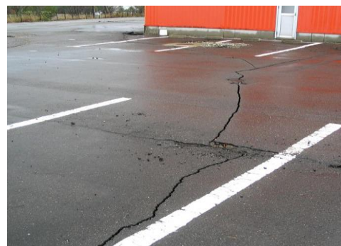
写3-2 宅地地盤のクラックの例
