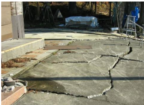
写3-2 宅地地盤のクラックの例
