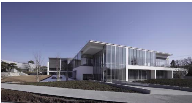
長野県立美術館 本館 外観
