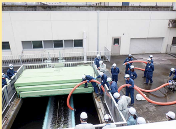
排水ポンプの設置及び運転訓練
