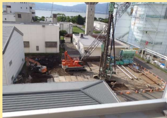
焼却灰搬出ホッパ棟の建設工事
