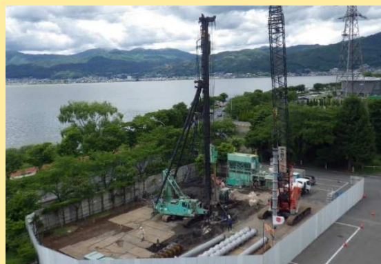
特高受変電棟の建設工事
