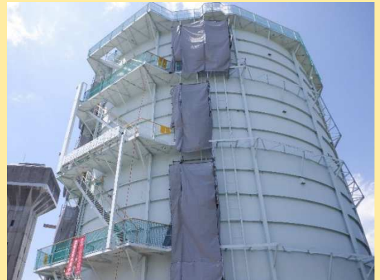
1号ガスタンの修繕
