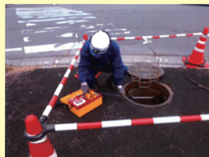
下水道管路の点検の様子
