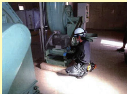
処理場設備の点検の様子
