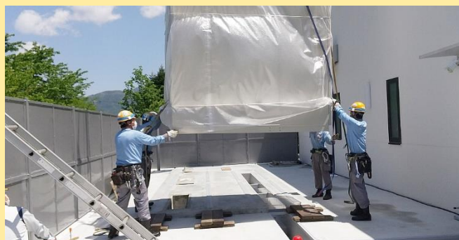
設置工事の状況
