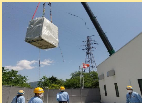
電気設備の設置工事
