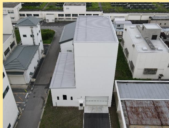
焼却灰搬出ホッパ棟（ドローン撮影）
