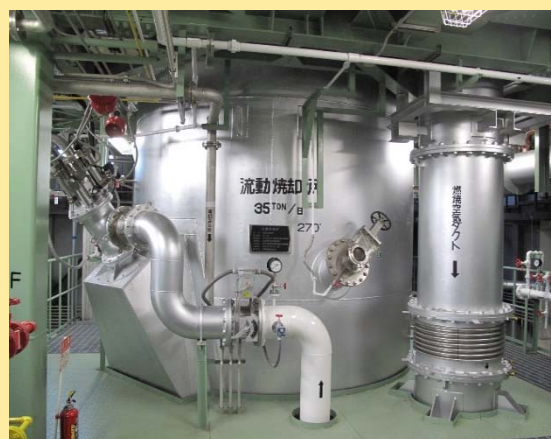
焼却炉の外観
