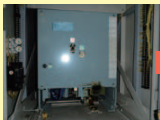
●電気盤内の高圧ブレーカーも新しくなりました
