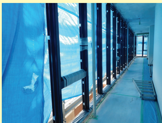
◆ 2F 見学者通路 工事の様子
