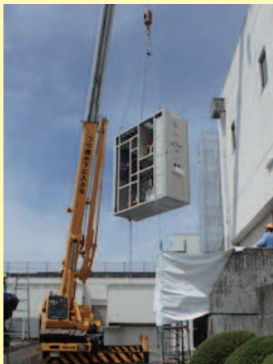
●クレーンによる電気盤の搬入
