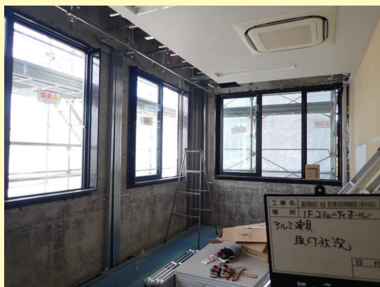
◆ 1F コミュニティホール 工事の様子
