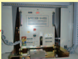
●電気盤内の高圧ブレーカーも新しくなりました
