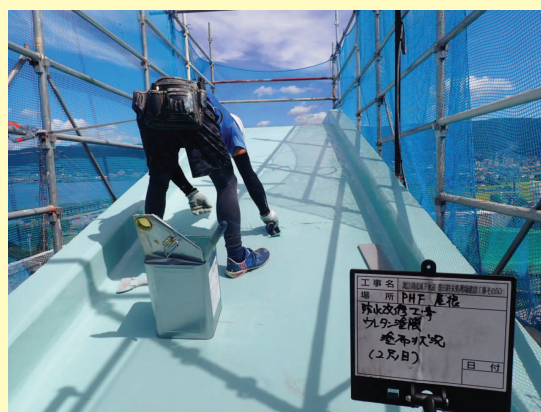
◆ 屋上 防水工事の様子
