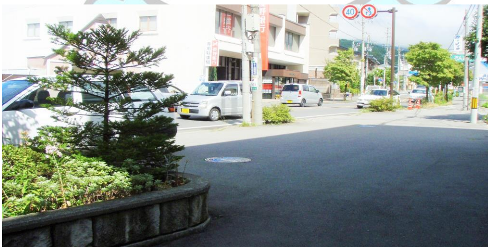
《歩道の地下に雨水貯留槽が設置されています》
