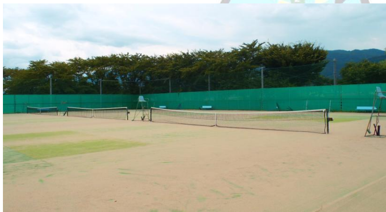
修繕前のテニスコート。 人工芝がだいぶ傷んできました。 これから、コートを均一に均し、 新しい人工芝に張り替えます。
