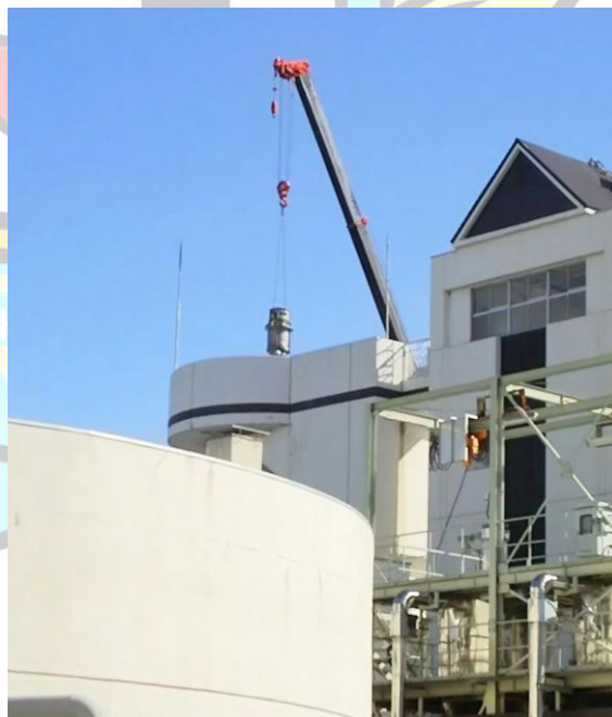
クレーンで攪拌装置を吊り上げます。 攪拌装置の上部分が上がってきました。
