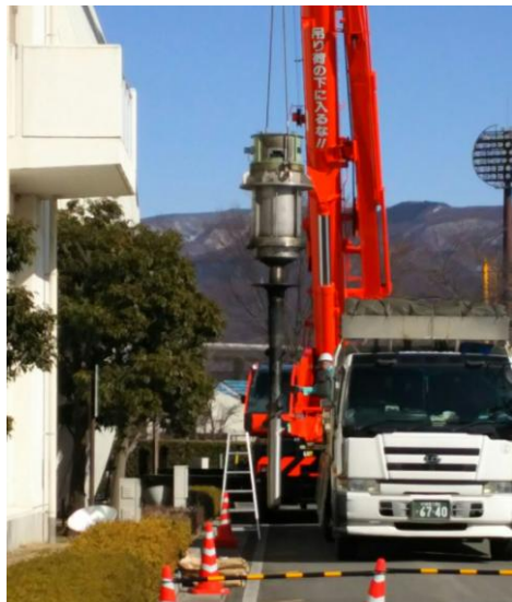
釣り降ろされた攪拌装置。搬出用のトラックと比較すると、その大きさがイメージできますか？
