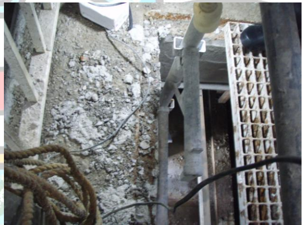
作業現場の床の部分。この下を下水が流れています。
