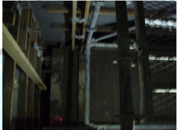
マンホール内部。暗くて分かりにくいですが作業用足場が組み立てられ、内部の動きはかなり制約を受けます。
