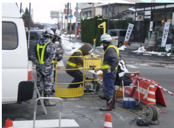
工事現場：黄色の手すりを設置されているのが工事対象のマンホールです。
