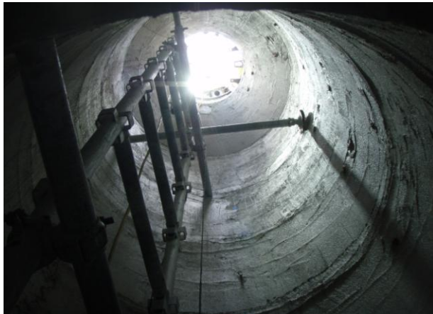
下から上を見上げた様子。マンホールの入り口が見えます。入り口から下が広がっている様子がわかります。
