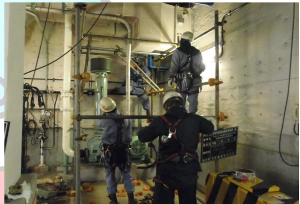
酸素発生装置の修繕の様子
