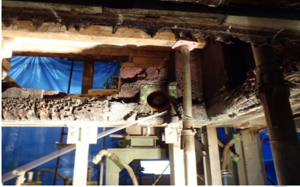
修繕中の溶融炉内部。熱に強いれんが（耐火れんが）の交換中です。
