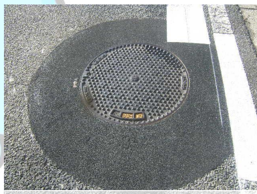
舗装を修繕。きれいになりました。
