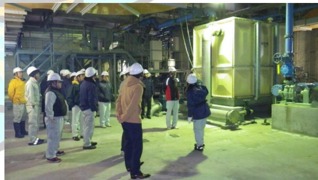
沈砂池を見学する様子
