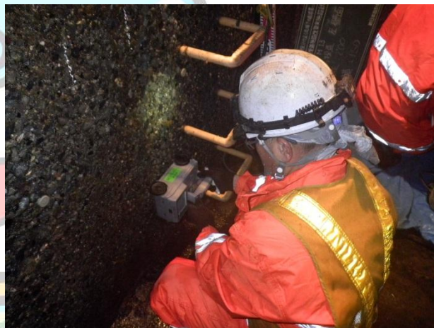
鉄筋の位置探査の様子
