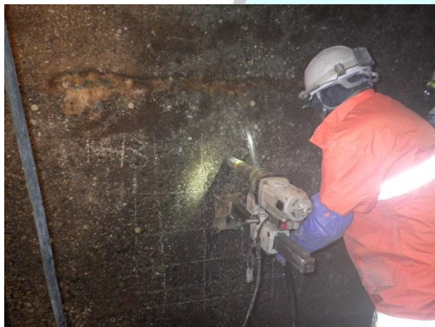
試験用のコンクリート採取の様子
