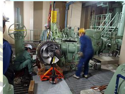
分解整備の状況
