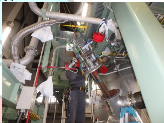
始動用バーナーの点検・交換作業
