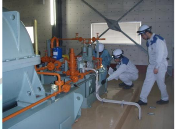
設備の損傷等を点検する様子
