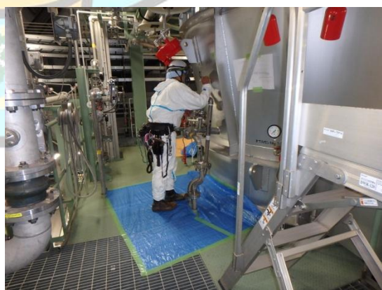
各種配管の点検作業
