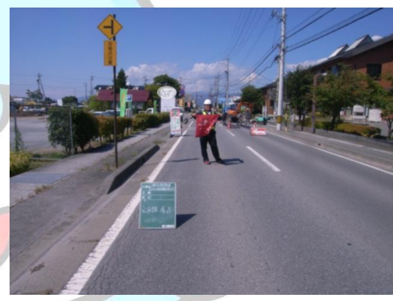
マンホール周辺舗装修繕交通誘導状況
