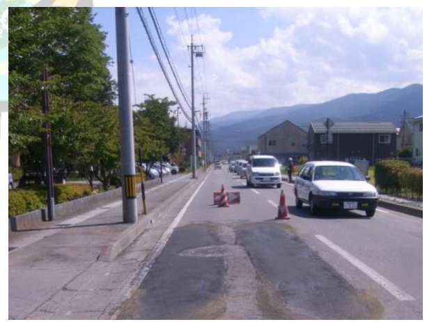
マンホール周辺舗装修繕工事完了後
