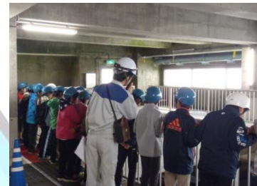
最終沈殿池を見学している様子
