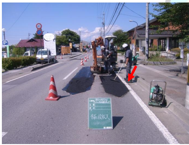
マンホール周辺舗装修繕作業状況
