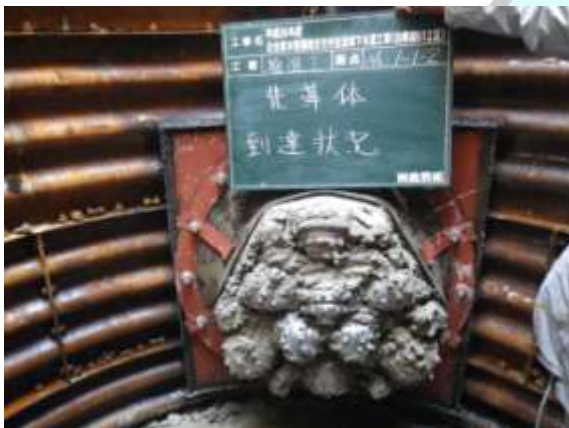
推進機械（先導体先端）が到達坑へ到達
