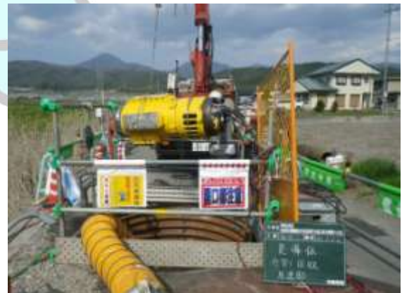
推進機械（先導体）の分割回収
