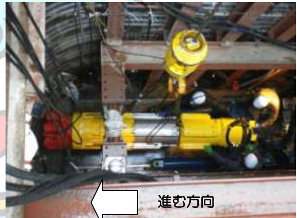
推進機械（先導体）を発進坑へ据付
