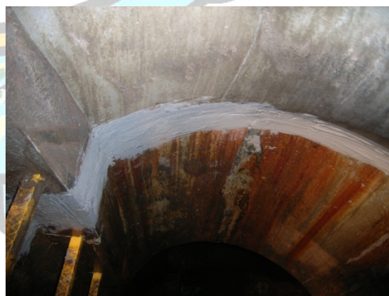
修繕工事完了
