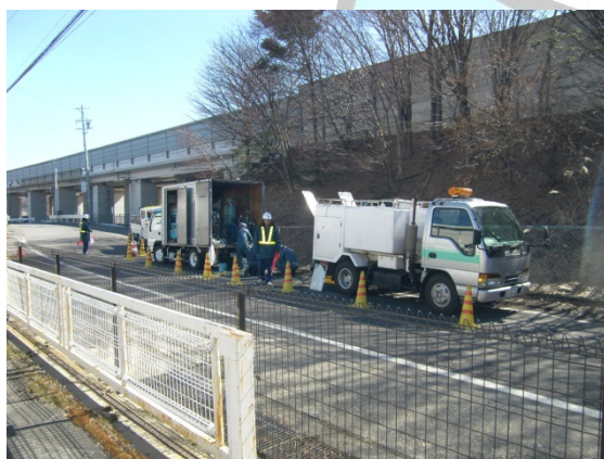
修繕作業の様子
