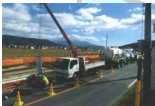
修繕作業の様子
