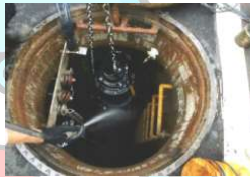
マンホールからポンプ引上げの様子
