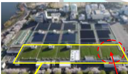
土壌脱臭設備
