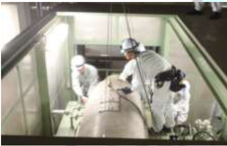
カバーの吊り上げ作業
