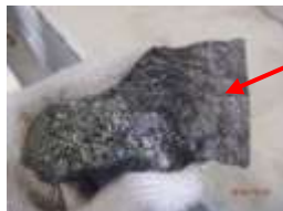
配管に溜まっていた灰の塊
