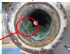
清掃前の配管の様子
