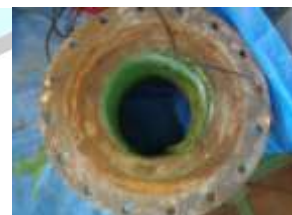
清掃後の配管の様子
