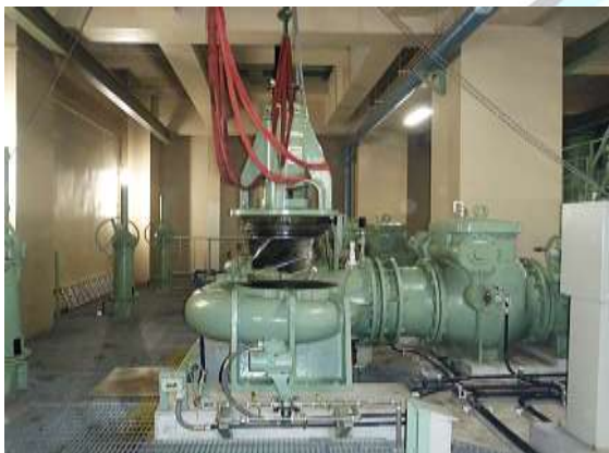
主ポンプの羽根車を引き揚げたところ
