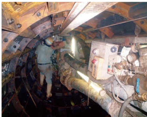
シールド工法(1次覆工)
