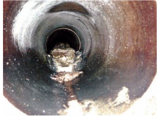
管路のロボットカメラによる調査
