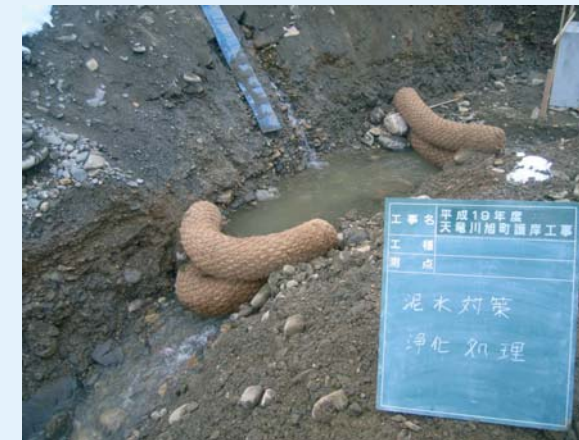
フィルターの設置
