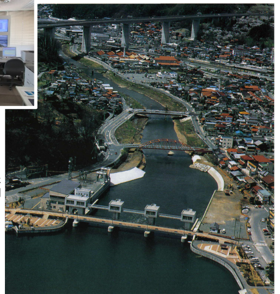
空から見た 釜口水門
