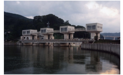
現(2代目)「釜口水門」昭和63年完成 (最大放流量 600m 3 /s)
