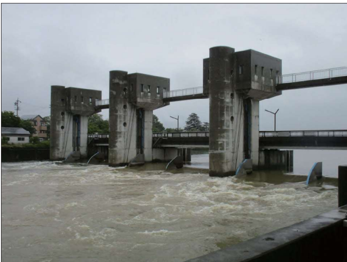
調節ゲート (洪水時)
